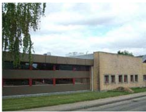
Figur 20: Anlægget er opstillet under jordniveau ved det gule bygningsafsnit. På taget ses kondensatoren.
