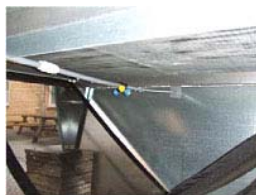
Figur 13: Placering af dyser, der sprayer mod net
