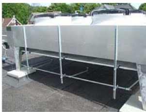
Figur 21: Kondensator med adiabatisk befugtersystem. Der anvendes langsomt gående ventilatorer i energiklasse A og dermed opnås også minimal lydbelastning (36 dBA i 10 m). Minimumkondenseringstryk styres til 15°C vha. frekvensregulering af blæserne.
